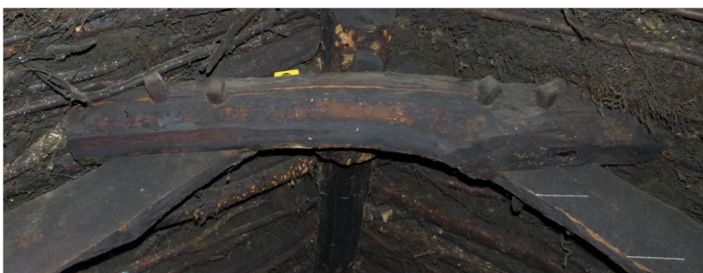
Afb. 5. (A) In een waterput hergebruikte koppelstukken uit Leens-Tuinsterwierden, die blijken hun afgeronde hoeken en oudere, grotere pengaten, oorspronkelijk in de top van beenspanen gebruikt kunnen zijn geweest (uit Postma 2015, afb. 247). (B) Koppelstuk in de top van Sunnybrae Cottage, een voormalig zodenhuis in Pitlochry, Schotland (foto: auteur).
